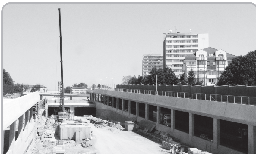
podářilo docílit toho, že investor zastřešuje aspoň oba krajní pruhy velkého městského okruhu u Voroněžské ulice v Brně. Sníží se tak hluková zátěž okolí.
