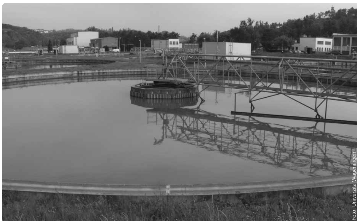
Jedna z usazovacích nádrží v ÚČOV Praha.
