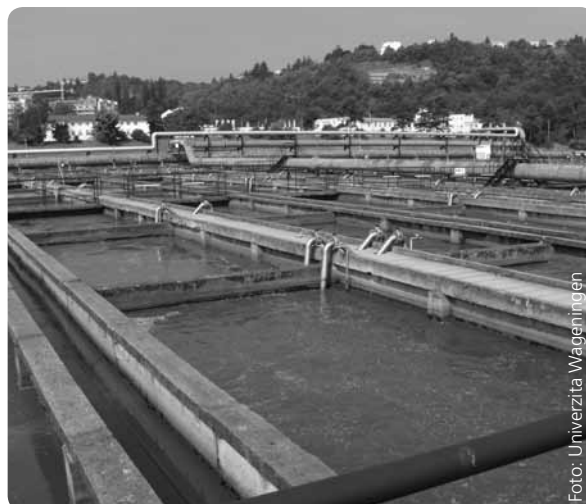
Aktivační nádrže s kalovou vodou v ÚČOV Praha.
